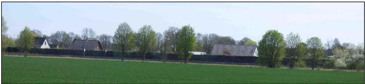
Abb. 17 Schallschutzwand im Bereich der Wohnbebauung Tornau in Richtung Süden
