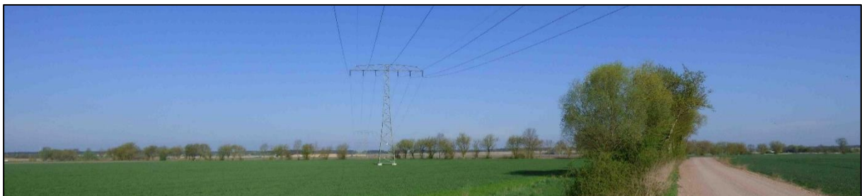
Abb. 19 Freileitung innerhalb des südwestlichen Bereichs der TF 2
