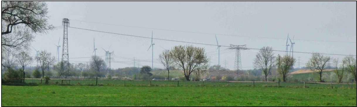
Abb. 16 Bahnstrecke mit Baustelle Autobahntrasse, Freileitung und Windkraftanlagen in Richtung Süden und Westen
